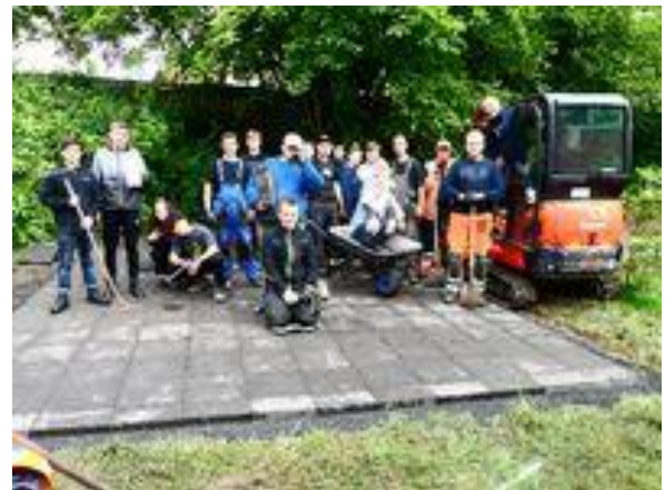
Fundamentbau für das Gartenhaus
